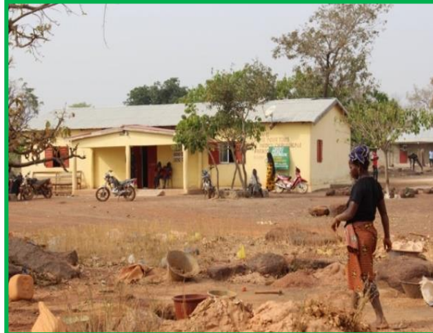
Centre de Santé de Farassababen en Guinée Conakry
