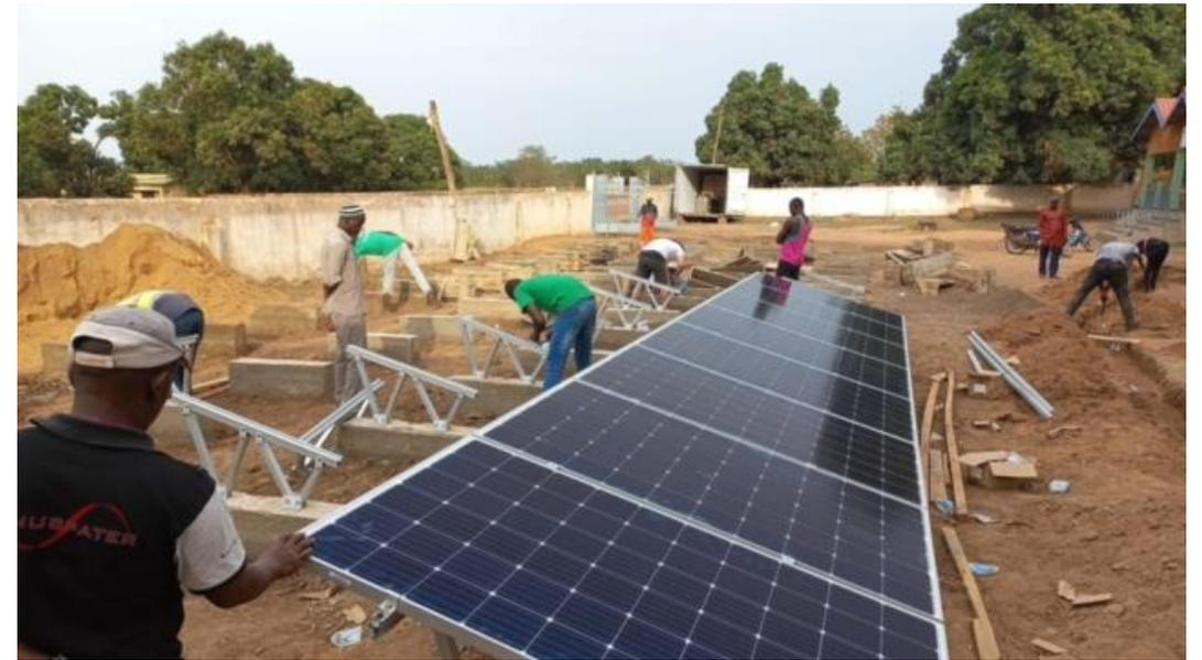
Réalisation d'une installation photovoltaïque de 27,2 kW (64 panneaux solaires, 24 batteries,...) pour alimenter le centre de santé et motoriser l'alimentation en eau
